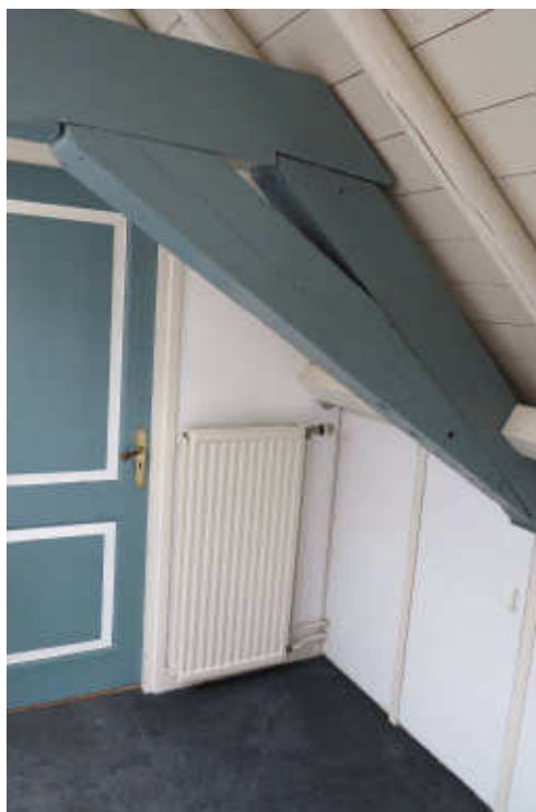
Afb.C26/27 Zolderverdieping nr.64 met oude spanten. [ GVB architecten 2017 ]
