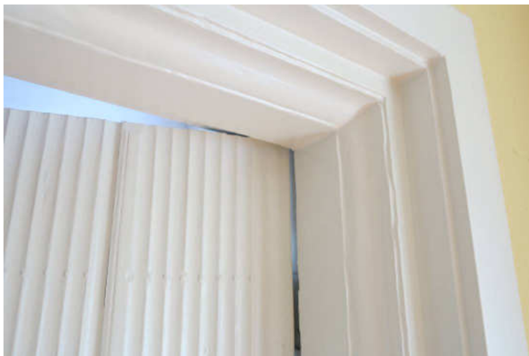
Afb.C35 Beganegrond. Achterkamer nr.66. Detail kamerdeur. [ GVB architecten 2017 ]
