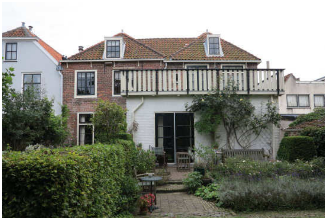
Afb.C10 Overzicht achtergevels. [ GVB architecten 2017 ]
