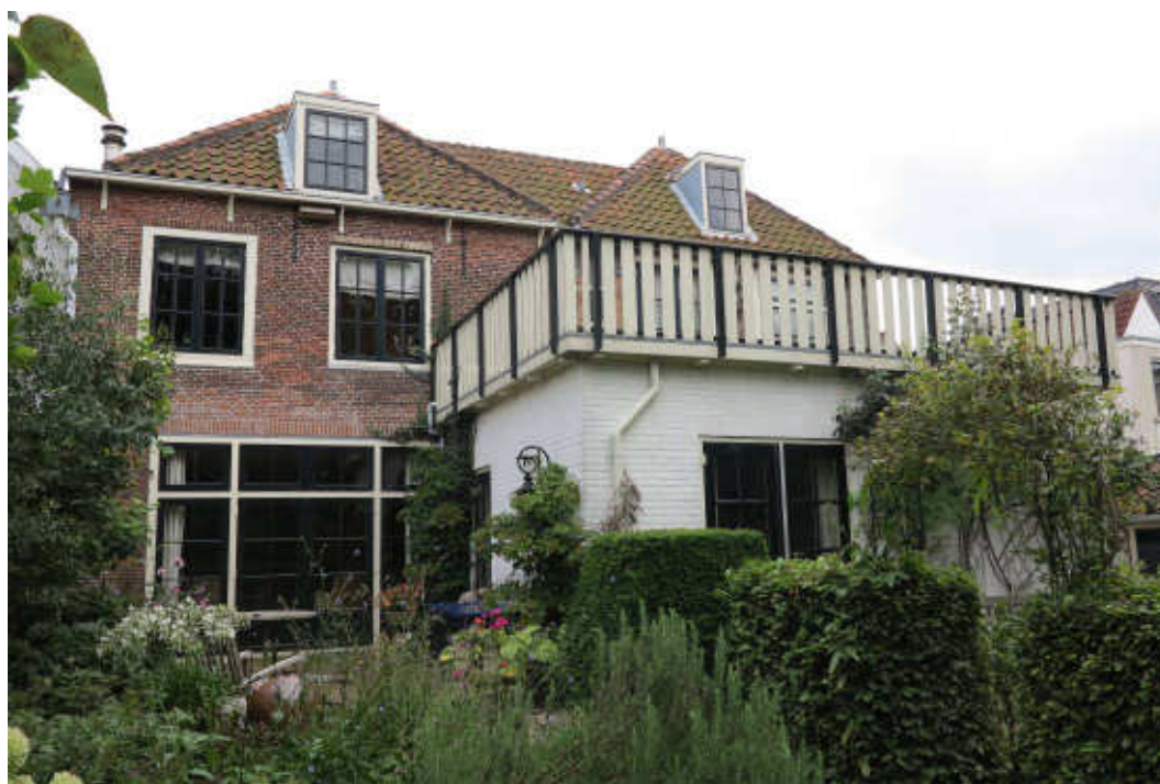
Afb.C11 Overzicht achtergevels. [ GVB architecten 2017 ]
