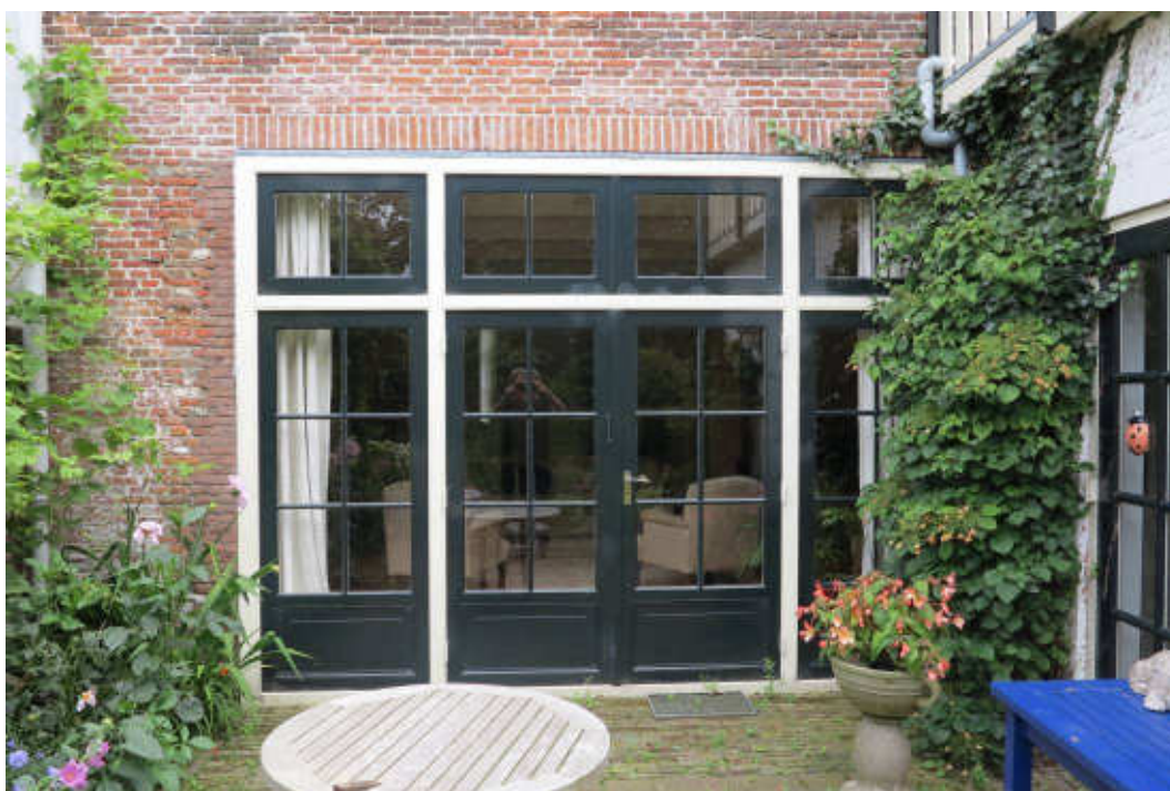
Afb.C13 Achtergevel nr.64 met pui daterend uit 1980. [ GVB architecten 2017 ]
