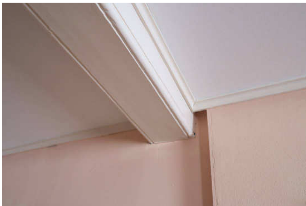
Afb.C23 Eerste verdieping voorkamer nr.64. Detail profilering balklaag. [ GVB architecten 2017 ]
