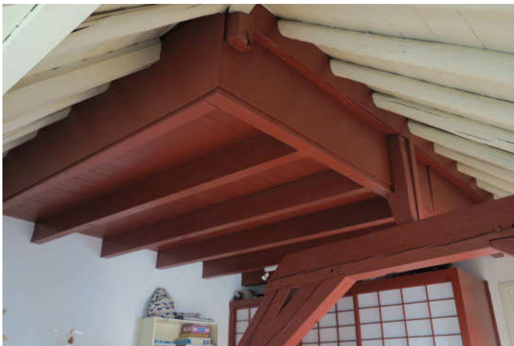
Afb.C28 Zolderverdieping nr.64. [ GVB architecten 2017 ]
