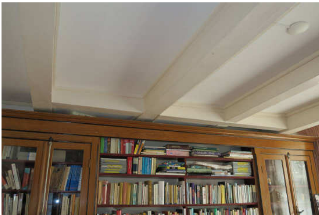
Afb.C17 Beganegron. Voorkamer nr.64. Balklaag met raveelconstructie. [ GVB architecten 2017 ]
