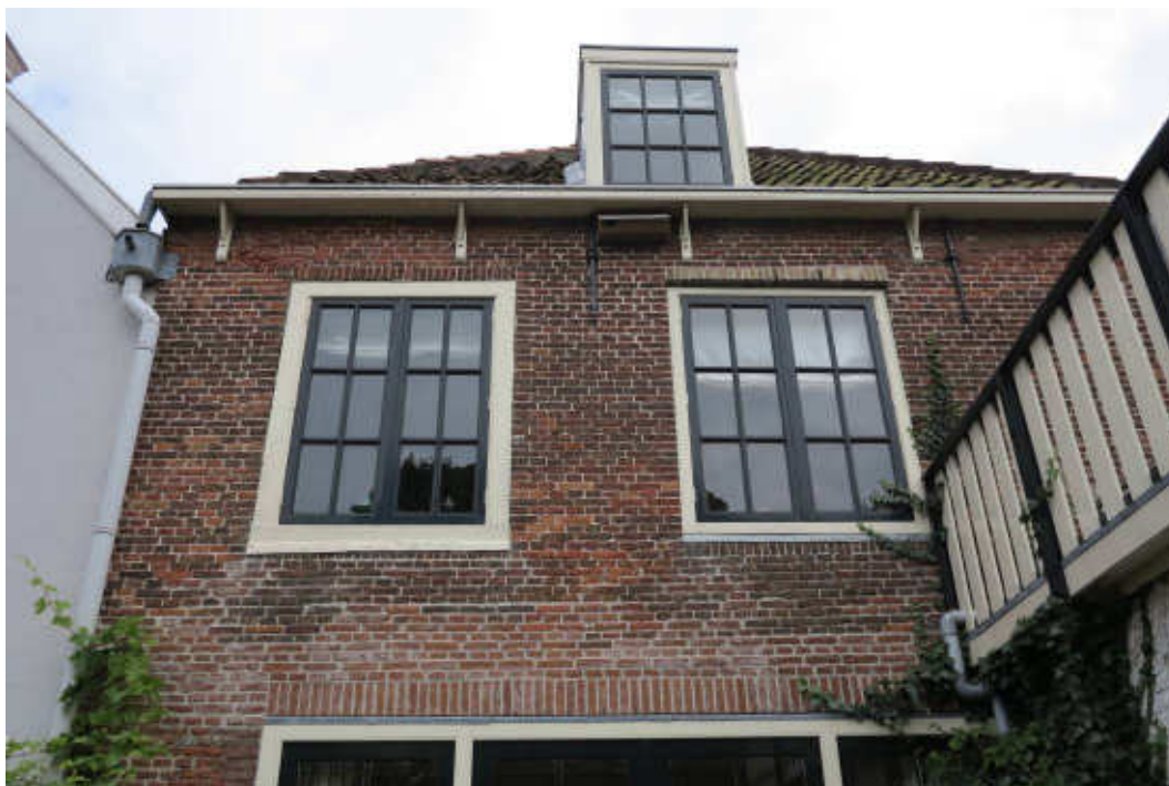
Afb.C12 Achtergevel nr.64. Linksboven een oud kozijn vermaakt met draairamen. Rechtsboven een nieuw kozijn. [ GVB architecten 2017 ]
