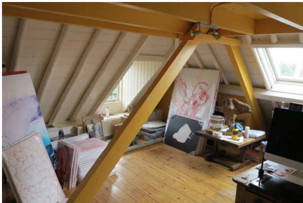
Afb.C43 Zolderverdieping nr.66 met vernieuwde kapconstructie na brand in jaren 1990. Voorkamer. [ GVB architecten 2017 ]
