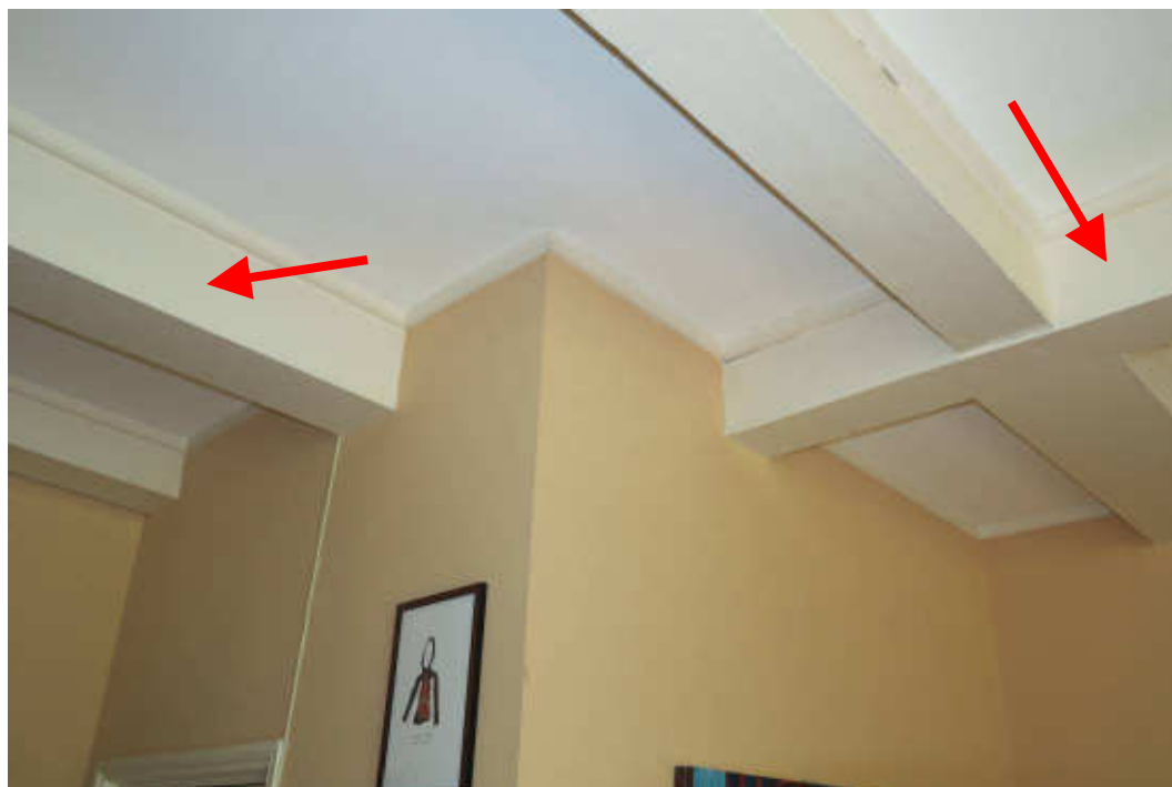
Afb.C21 Beganegrond. Achterkamer nr.64 met omtimmerde stalen balken. [ GVB architecten 2017 ]
