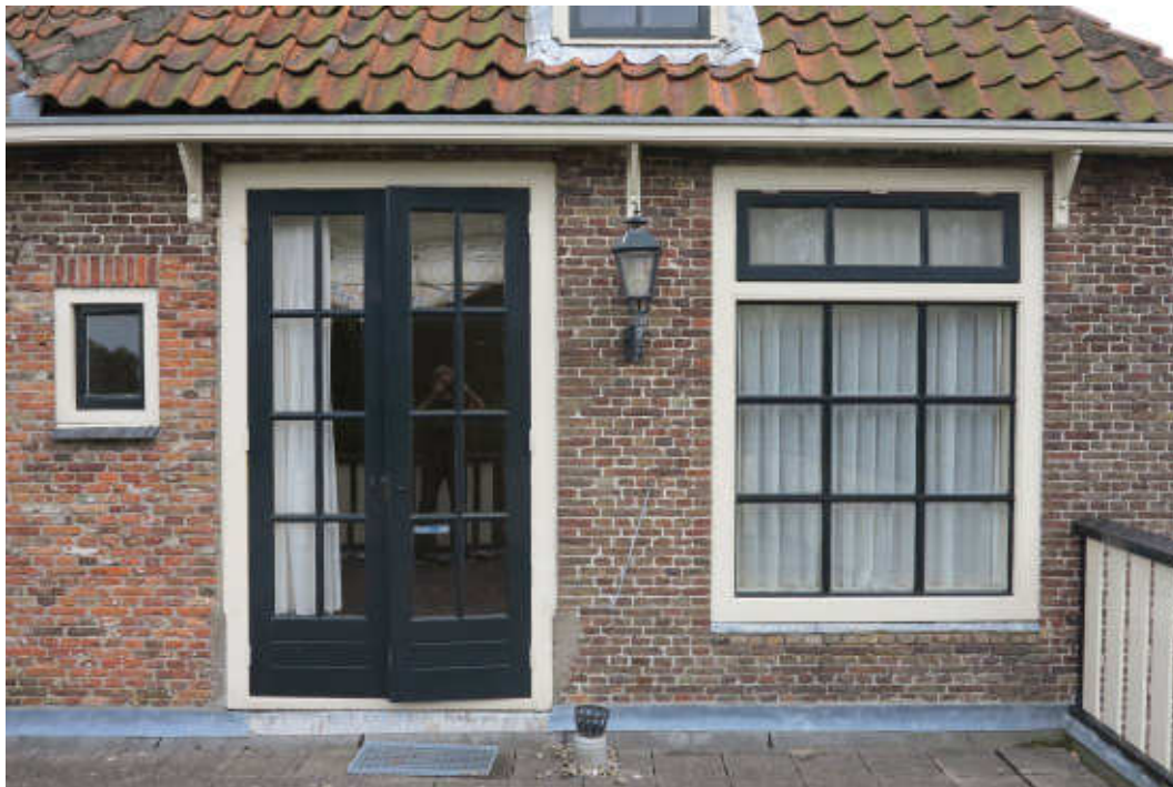
Afb.C14 Achtergevel verdieping nr.66. Links een oud vensterkozijn vermaakt tot deurkozijn. Rechts een nieuw kozijn met een a-historische raamindeling. [ GVB architecten 2017 ]
